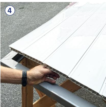
4 Nachdem Sie alle vier Füllungsleisten entfernt haben, können Sie die Füllung entnehmen und z. B. eine beschädigte Lamelle austauschen.
