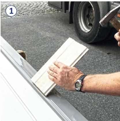
1 Setzen Sie den Holzklötz schräg an der Kante der Füllungsleiste an und schlagen Sie mit dem Hammer in Richtung Füllung.
