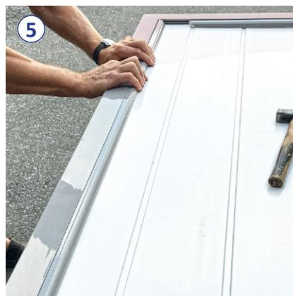
5 Der Wiedereinbau der Füllung erfolgt in umgekehrter Reihenfolge. Wenn die Füllung eingelegt ist, Füllungsleisten nacheinander mit der Hand in ihre Führungen eindrücken.
