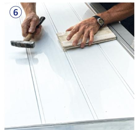
6 Abschließend klopfen Sie die Füllungsleisten mit dem Hammer und dem Holzklötz wieder fest.
